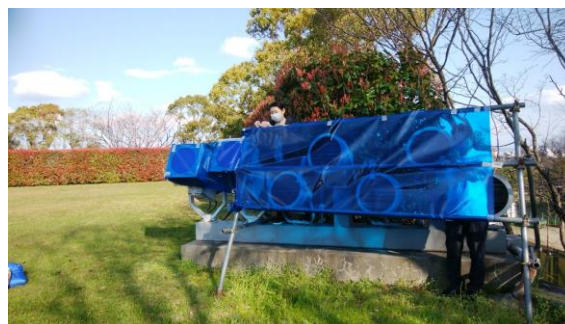
シート貼り付け
